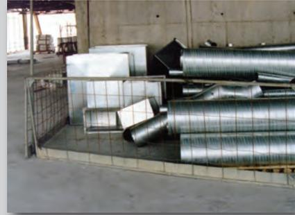
Placer les matériaux dans une zone réservée et délimitée permet de garder les allées et les zones de travail dégagées.
