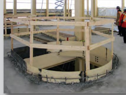
Recouvrir ou sécuriser toute ouverture dans le plancher pour éviter une chute.
