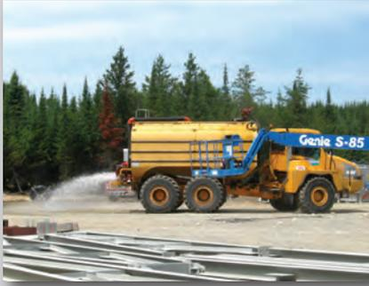
Arroser les voies de circulation pour les véhicules de chantier afin d'éviter le soulèvement de poussières.
