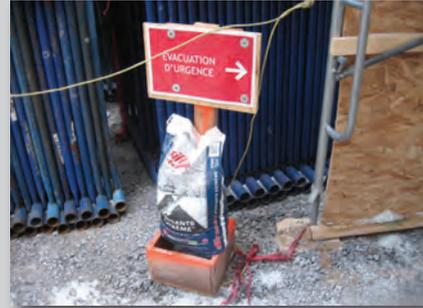
Installer des sacs de sable au pied d'une affiche directionnelle afin de rappeler l'application régulièrement d'abrasif sur les voies de circulation rendues glissantes par la glace et le froid.
