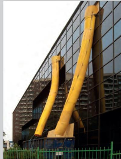
Évacuer les rebuts au fur et à mesure, dans un contenant adéquat ou à l'aide d'un conduit aboutissant dans un récipient approprié.
