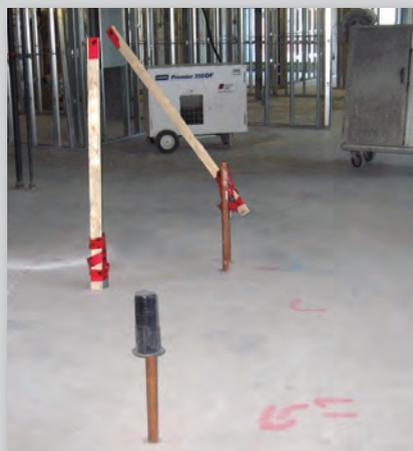
Recouvrir d'un capot de plastique ou rendre plus visibles à l'aide de rubans et de lattes de bois les embouts de tuyaux qui ne peuvent être enlevés afin de minimiser le risque de blessure.
