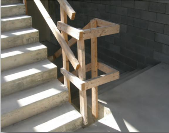
S'assurer que les moyens d'accès soient dégagés de rebuts ou de matériaux pour faciliter la circulation, et qu'ils soient aménagés conformément à la réglementation.
