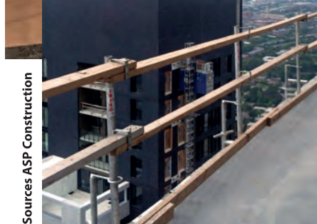
Garde-corps métalliques avec lisse supérieure, traverse intermédiaire et plinthe en bois
