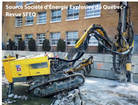
Excavation à l'explosif à proximité d'un bâtiment à Montréal, Entrepreneur « Dynamitage LaFontaine ».
