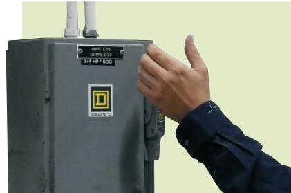
Cette fiche présente les pratiques sécuritaires à suivre pour manœuvrer un dispositif de sectionnement, par exemple, lors de l'application d'une procédure de cadenassage sur un appareillage.
